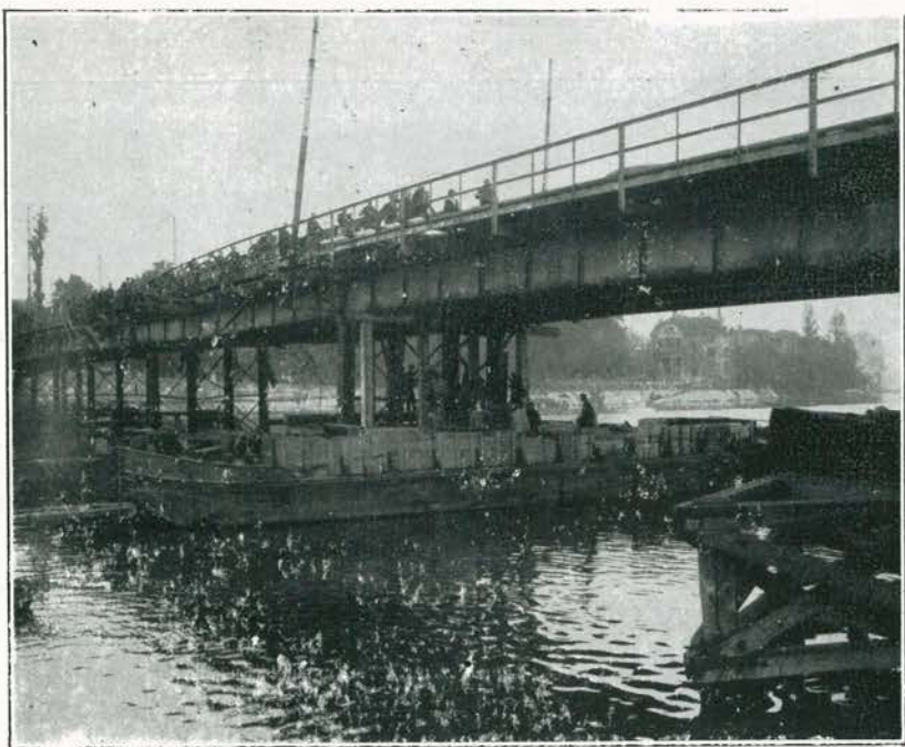
PONT DU COMMERCE BRIDGE, LIEGE, BELGIUM
