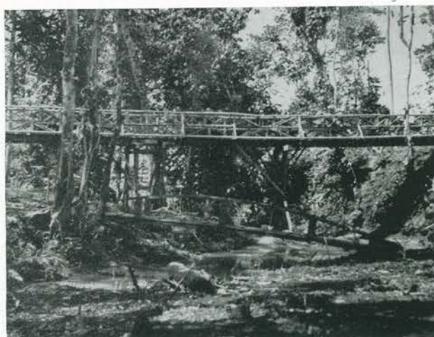
BRIDGE TO B. O. Q.
